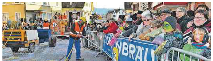
Die Kollegen aus Diepoldsau sind jetzt in Rebstein am Werk. Der Zubringerdienst bis zur Baustelle ist gestattet.
